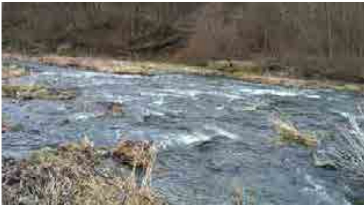
Fot. 2.6 Podniesienie i odtworzenie korony bystrza przez wprowadzenie kamieni – wywołało samorzutne zasypanie przez rzekę wyrwy w dnie, podmywającej stopień położony powyżej. Forma wykonania Działania 5.1. Fot. I. Biedroń
