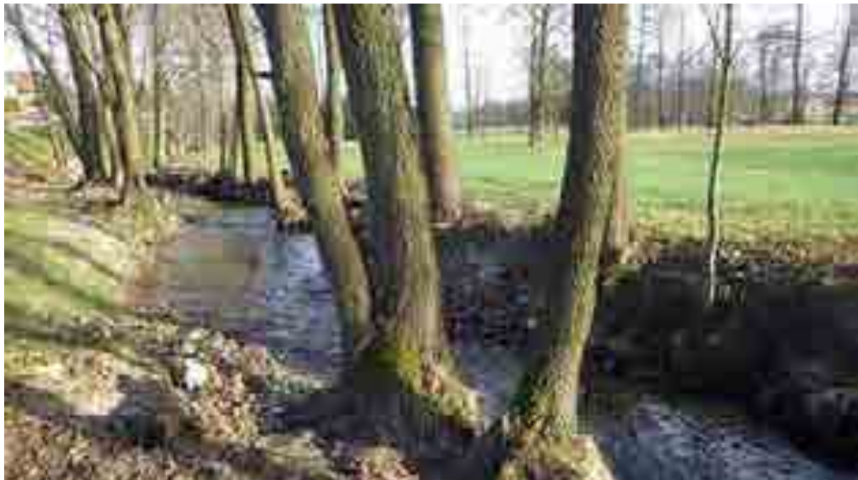
Fot. 2.3 Ciek po selektywnym usunięciu pojedynczych drzew z jego brzegów (Działanie 3). Zachowano jednak stabilizację brzegów przez drzewa oraz pozytywny wpływ drzew na zróżnicowanie koryta. Fot. I. Biedroń
