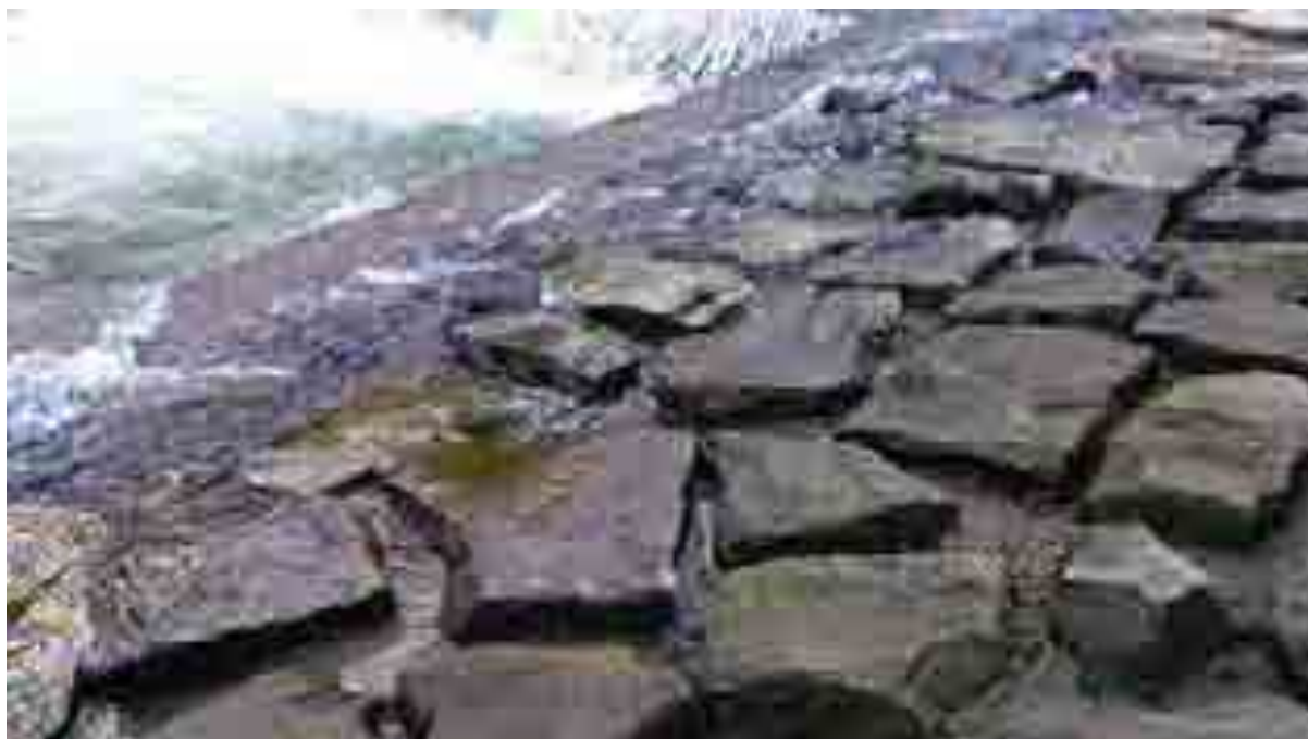
Fot. 7.14 Powierzchnia wykonana w technologii grouted rock (kamień częściowo osadzony w betonie). Fot. I. Biedroń
