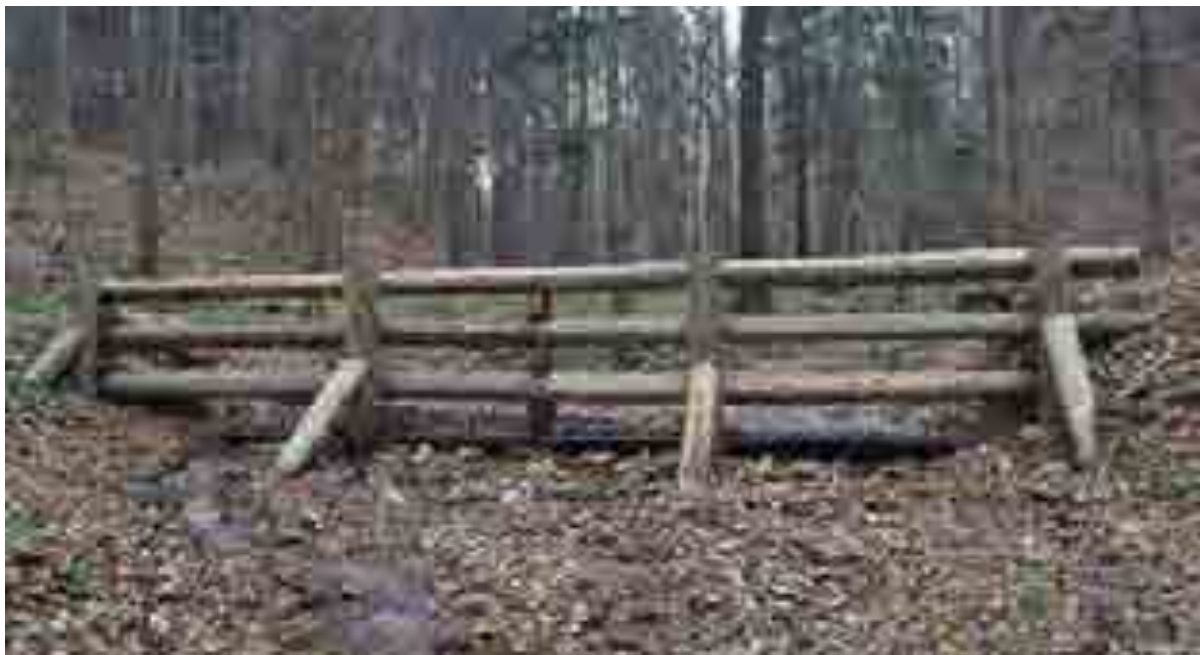
Fot. 7.8 Łapacz rumoszu drzewnego zbudowany na potoku w nadleśnictwie Prudnik, w pobliżu wypływu z lasu. Umożliwia pozostawianie martwych drzew na całym leśnym odcinku potoku, bez stwarzania zagrożenia zatkania przepustów wśród zabudowy poniżej. Źródło: archiwum Lasów Państwowych
