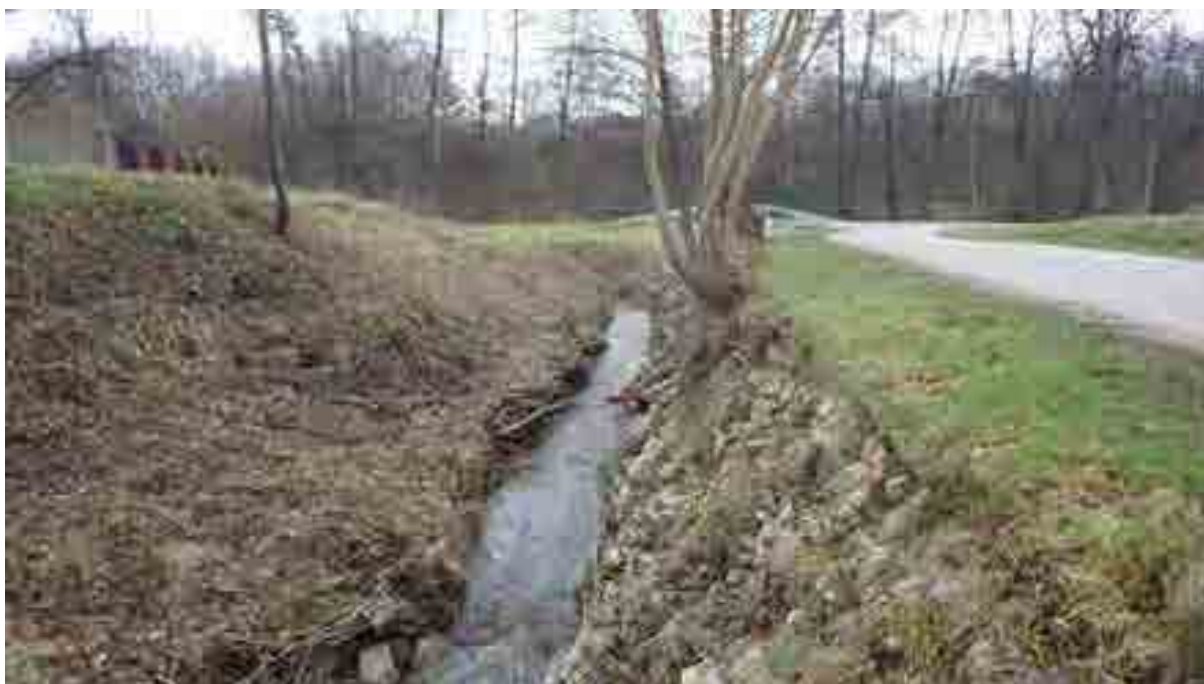
Fot. 2.1 Wykazane brzegi cieku (Działanie 1.1) przeprowadzanego przez gorset infrastruktury. Fot. I. Biedroń
