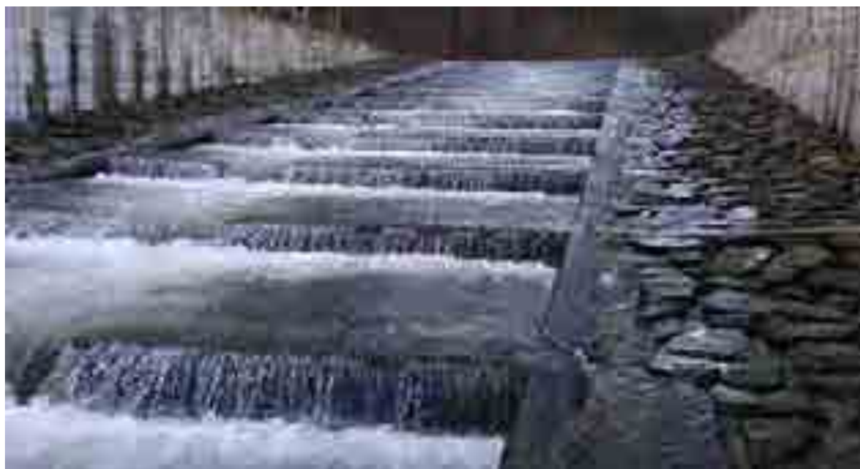
Fot. 7.13 Przebudowana zapora przeciwrumowiskowa, drożna dla ryb przy różnych stanach wody oraz częściowo drożna dla rumowiska rzecznego. Rozłożenie spadku na kilka stopni sprawia, że są one możliwe do pokonania dla ryb. Ukształtowanie przelewów zapewnia drożność także przy niskich stanach wody, a szerokie światło i brzegi ukształtowane w technologii grouted rock przeprowadzają przepływy wysokie i dają możliwość migracji organizmów wodnych w szczelinach między kamieniami. Fot. I. Biedroń
