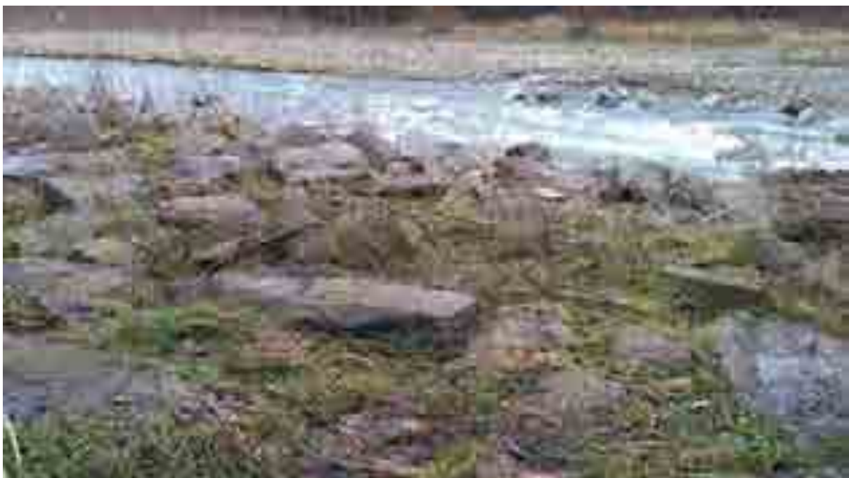
Fot. 2.13 Deflektor ukierunkowujący nurt wykonany przez umieszczenie w korycie rzeki górskiej dużych głazów (Działanie dodatkowe 10), po kilku latach wtopiony już w brzeg i koryto rzeki. Fot. I. Biedroń
