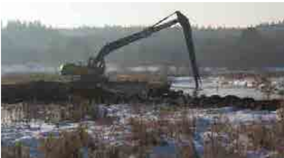
Fot. 2.9 Usuwanie namulów (Działanie 6.2). Fot. M. Grygoruk
