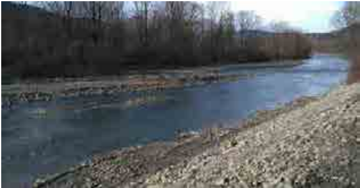
Fot. 2.10 Wykonane przemieszczenie żwirów w korycie (Działanie 6.3), dla ukierunkowania nurtu i zapobieżenia jako awulsji do innej odnogi. Żwir pozostawiono jako uformowaną w korycie wyspę, która przy najbliższym wezbraniu zostanie rozmyta, a materiał włączony w transport rumowiska poniżej. Fot. I. Biedroń
