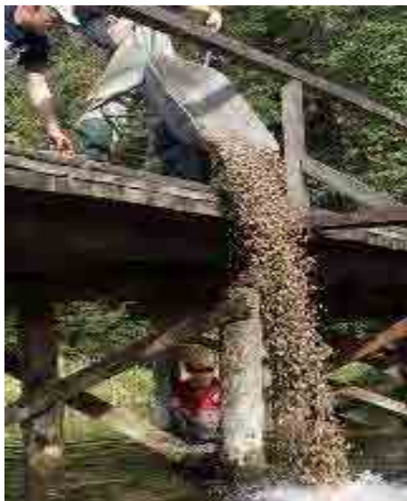
Fot. 7.12 Wykonywanie tarlisk dla pstrągów potokowych powinno być prowadzone w miejscach, gdzie wcześniej stwierdzano naturalne tarło tych ryb. W celu ułatwienia logistyki prac, kontroli efektywności wykonanych tarlisk oraz ochrony trących się ryb, tarliska najlepiej wykonywać w miejscach o ułatwiony dostęp do wody (np. poniżej mostów i kładek, w pobliżu dróg). Fot. P. Lisowski
