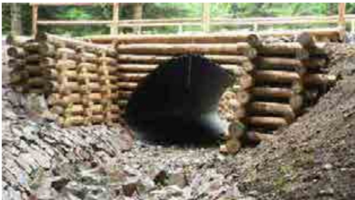
Fot. 7.15 Przebudowa przepustu na większy (przyczółki z drewnianych kaszyc) wraz z budową kamiennego bystrza oraz umocnienie brzegów potoku narzutem kamiennym i nasadzeniami roślinnymi. Fot. E. Skiba
