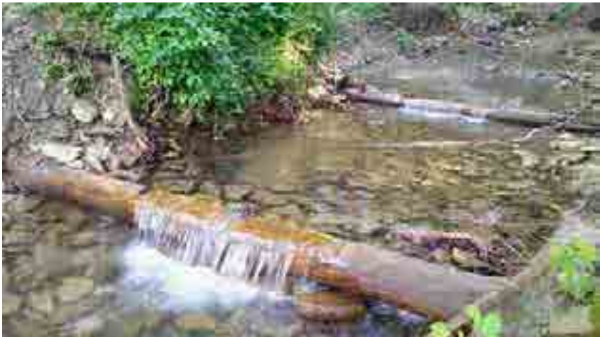
Fot. 1.4 Progi drewniane na potoku górskim.. Fot. I. Biedroń
