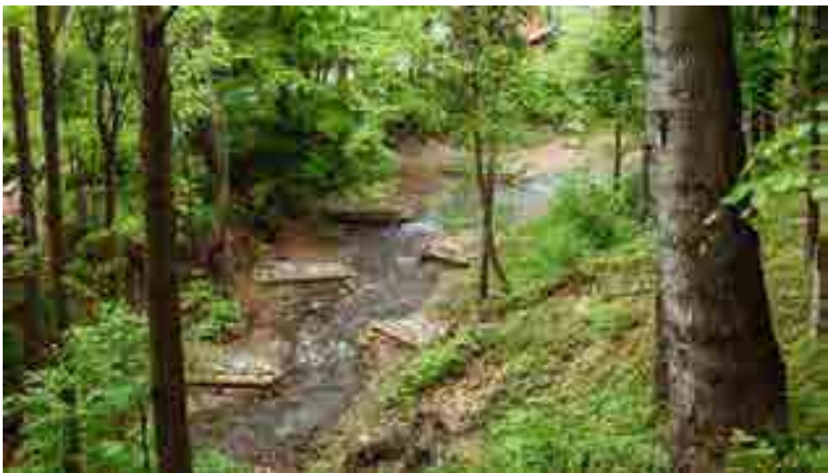
Fot. 1.3 Zabudowa ostrogami koryta potoku górskiego → Załącznik D pkt. 9. Źródło: archiwum Lasów Państwowych
