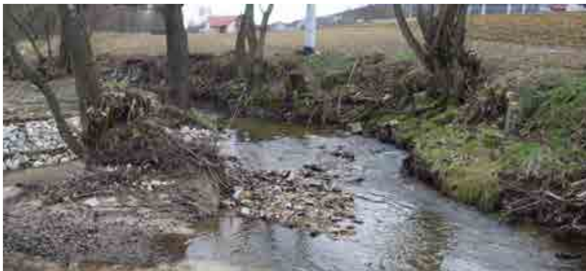
Fot. 5. Usuwając rumosze mineralny (namuły) oraz zalegający w korycie rumosze drzewny zachowano naturalnie ukształtowaną wyspę w korycie oraz odsyp żwirowy. Fot. I. Biedroń
