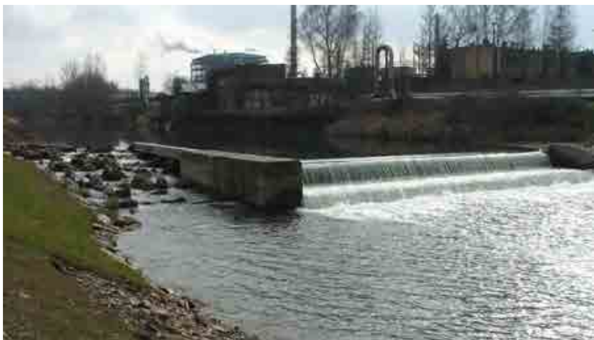
Fot. 22. Stopień na Wisłoce w km 107+200 w miejscowości Jasło po przebudowie. Udrożnienie bariery migracyjnej dla organizmów wodnych polegało na wykonaniu bystrotoku kaskadowego na prawym brzegu rzeki. Fot. P. Sobieszczyk
