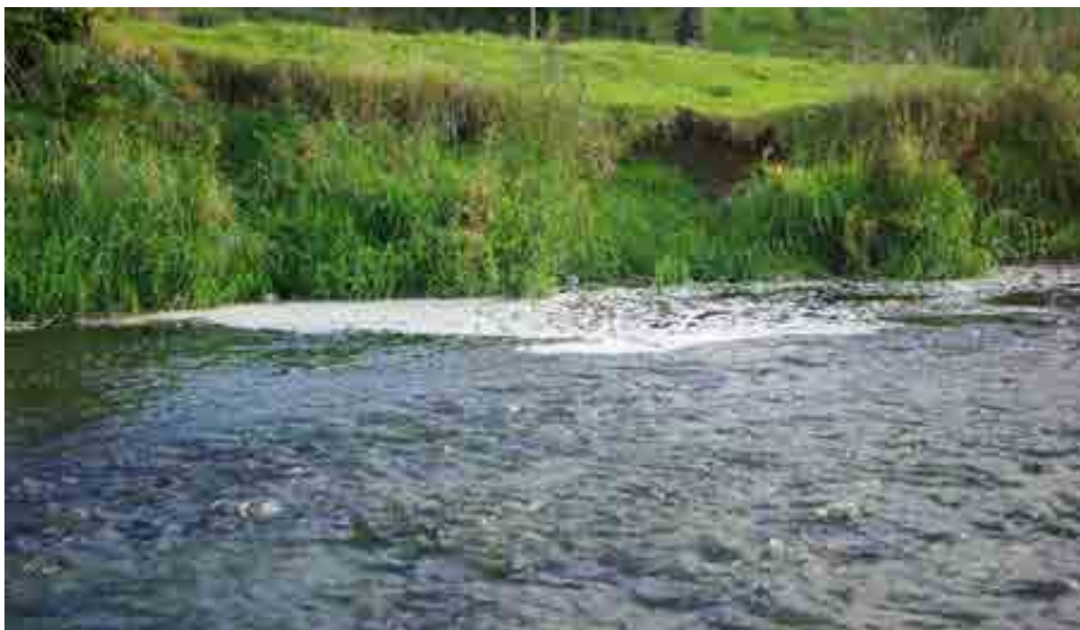
Fot. 16. Stabilne podcięcie brzegu niezagrożone nadmierną erozją boczną, utrwalone w wyniku dobrze zaplanowanych robót hydrotechnicznych. Źródło: Pietruczuk i in., 2017 - archiwum WWF Polska
