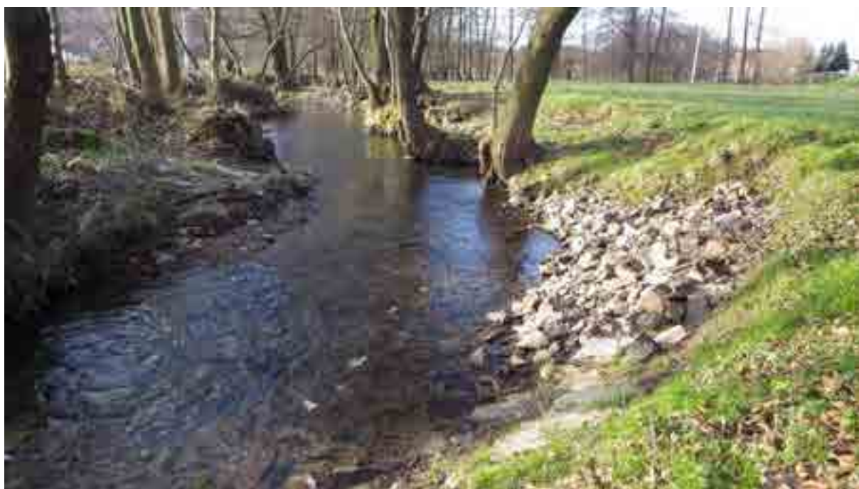
Fot. 4. Punktowe usunięcie wyrwy w brzegu z wykorzystaniem materiału rodzimego pochodzącego z koryta cieku. Zachowane drzewa na brzegach cieku stanowią naturalne zabezpieczenie przeciwoerozyjne. Fot. I. Biedroń
