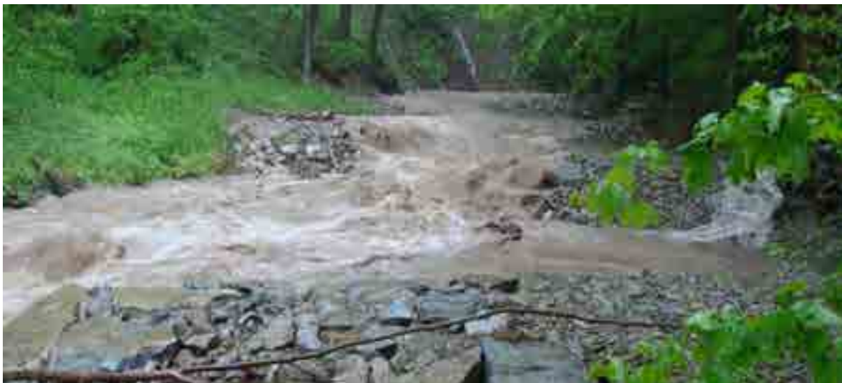
Fot. 18. Przeprowadzone roboty hydrotechniczne umożliwiły ograniczenie erozji bocznej i utrzymanie cieków w granicach wyznaczonego geodezyjnie koryta, nawet w warunkach wysokiego przepływu. Fot. A. Myśliwiec
