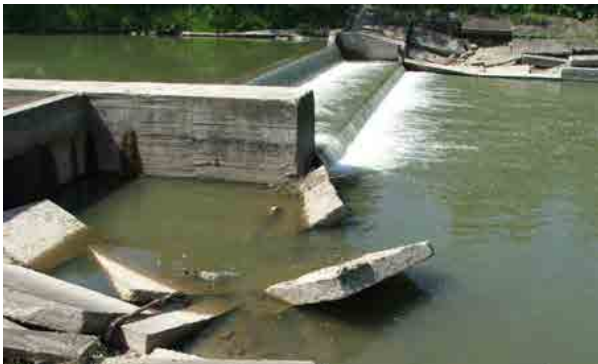
Fot. 21. Stopień na Wisłoce w km 107+200 w miejscowości Jasło przed przebudową. Fot. P. Sobieszczyk
