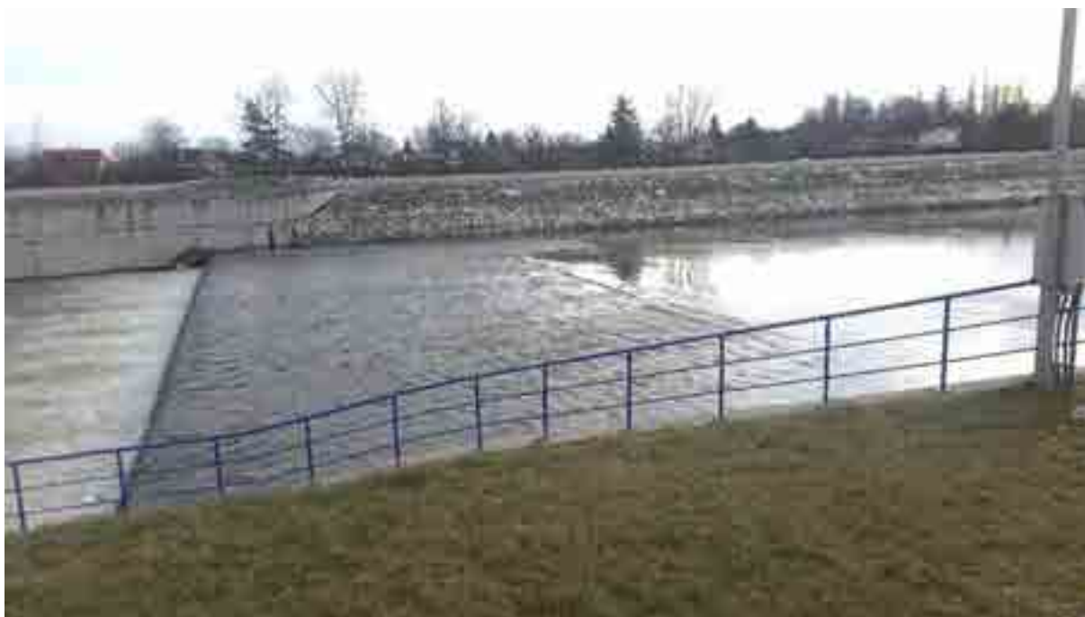
Fot. 13. Widok na jaz stały w km 61+256 - na zdjęciu widoczny murek przeciwpowodziowy oraz przebudowany jaz stały wraz przepławką dla ryb. Fot. M. Olszar
