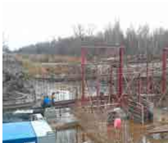
Fot. 10. Budowa jazu w korycie Kan. Woźnawiejskiego. Na czas budowy elementów konstrukcyjnych jazu wody kanału skierowano do koryta okrężającego plac budowy, przy zachowaniu oszczędności wykorzystania terenu. Fot. M. Grygoruk
