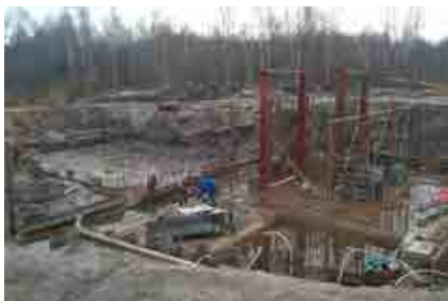
Fot. 10. Budowa jazu w korycie Kan. Woźnawiejskiego. Na czas budowy elementów konstrukcyjnych jazu wody kanału skierowano do koryta okrężającego plac budowy, przy zachowaniu oszczędności wykorzystania terenu. Fot. M. Grygoruk
