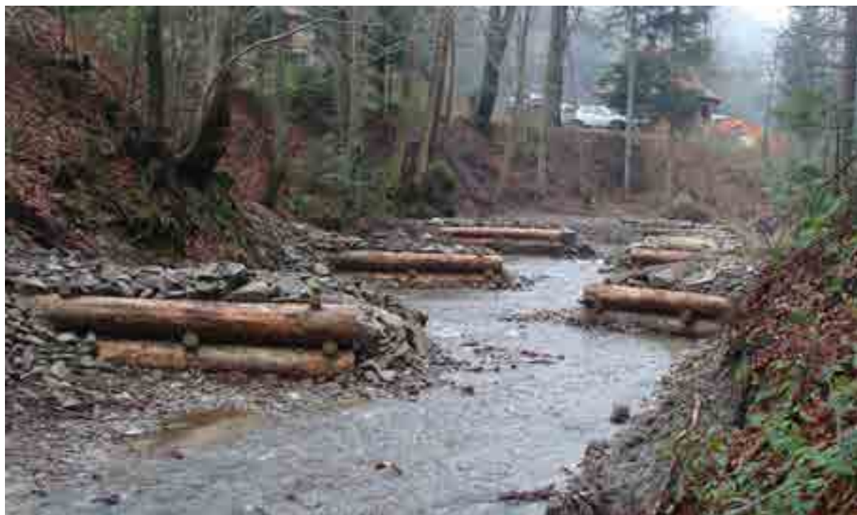
Fot. 17. Zabudowa ostrogami koryta potoku górskiego. Fot. A. Myśliwiec
